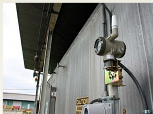
Honeywell: 温度伝送器
