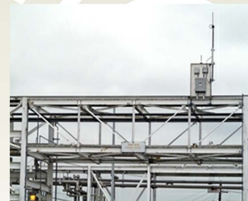
Honeywell: バックボーンルータ Nivis: ゲートウェイ
