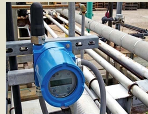
Gastronics: SO2 ガス検知器
