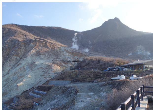
写真5.3.6.1 無線ガス検知器の設置場所
