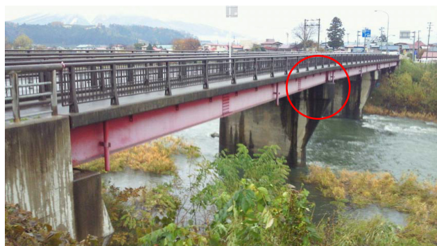
写真5.2.4.1 現場測定ポイント
