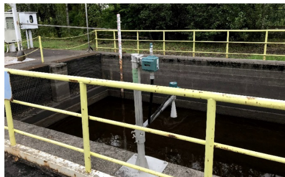
写真5.1.6.1現場の様子：炭塵沈降槽に溜まった排水量のレベル監視 従来は直読式の水位計を使用していた
